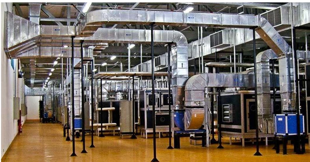
**Figura 21:** Rede de dutos em chapa de aço galvanizado
